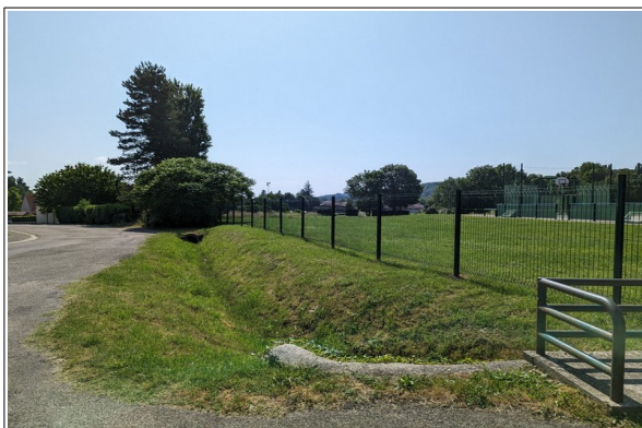
Figure V.36 : Le fossé de la dérivation du ruisseau des Moulins peut capter des écoulements et inonder les propriétés adjacentes.
