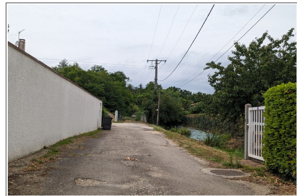
Figure V.25 : Sur Gattaz-Fer le fossé peut être submergé et les maisons atteintes par les débordements.
