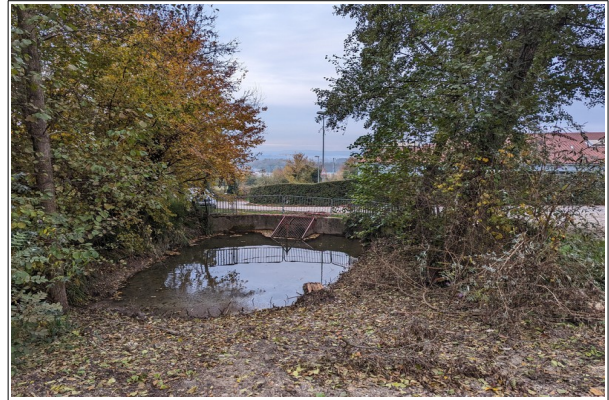
Figure V.17 : Second bassin décanteur. Dans le cas d'embâcles sur la grille, l'ouvrage peut être submergé. Les écoulements empruntent alors l'Avenue des Noyers.
