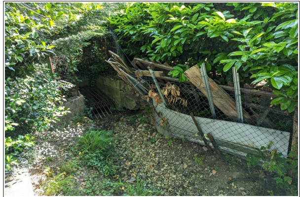
Figure V.11 : Grille avant le busage qui traverse le bourg.
