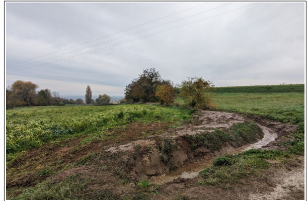
Figure V.23 : Ruisseau du Revollay / Gattaz-Fer dont le fossé a été curé et recreusé suite aux débordements de l'automne 2023.
