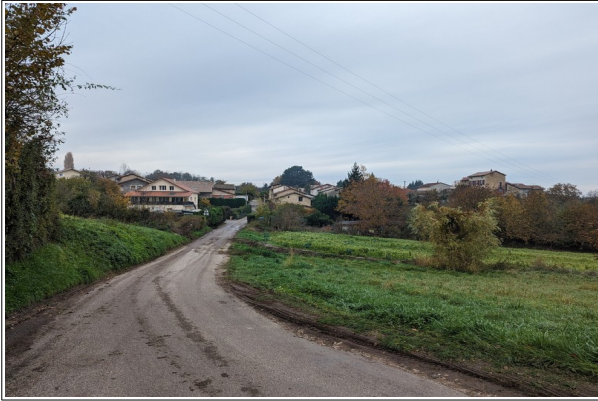
Figure V.22 : Ruisseau du Revollay / Gattaz-Fer peut submerger la route en fond de combe.
