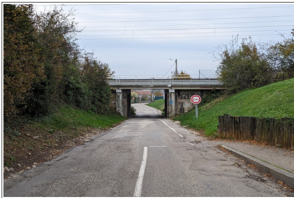
Figure V.18 : La lame d'eau débordante emprunte l'Avenue des Noyers jusqu'à atteindre la route de Lyon en limite de Bourgoin-Jallieu.
