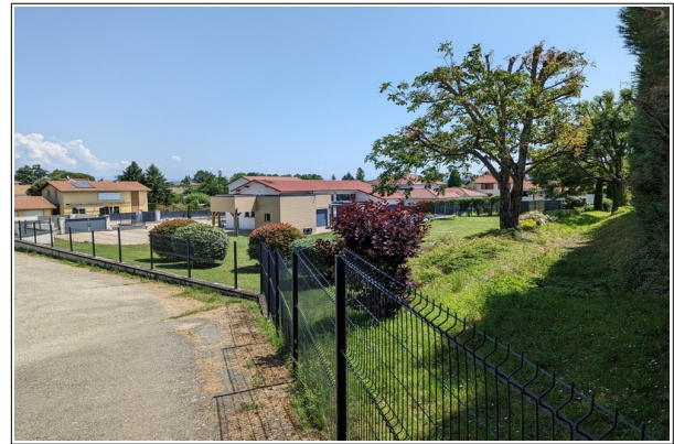
Figure V.29 : Ruissellement venant de la voirie et de la dérivation du ruisseau des Moulins (fossé) pouvant atteindre des maisons.
