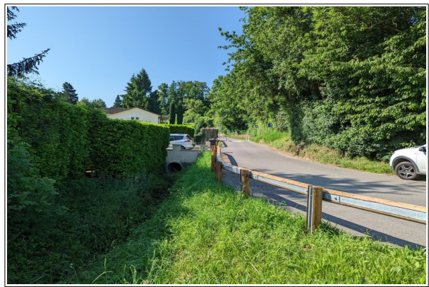
Figure V.13 : Fossé qui jouxte des maisons pouvant être atteintes en cas de crue.
