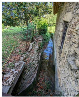
Figure V.12 : Sortie du ruisseau sous une maison après la traversée souterraine du bourg.
