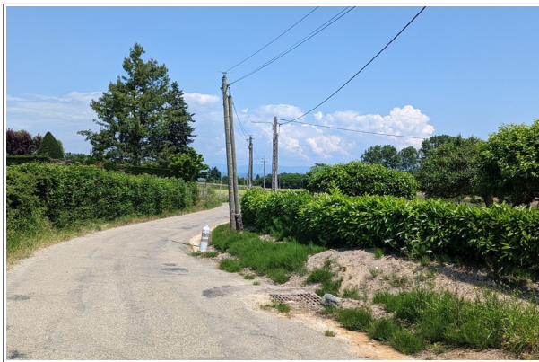
Figure V.34 : Ruissellements sur la voirie au Bois.
