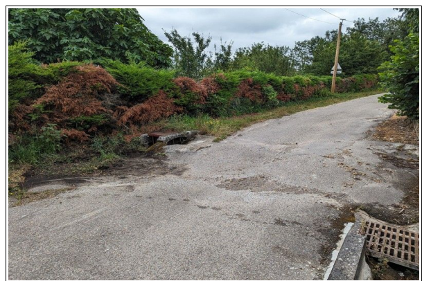
Figure 31 : Passage busé sous la route qui connaît souvent des débordements.
