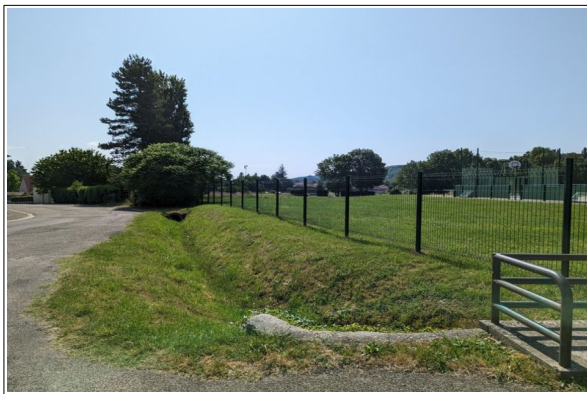
Figure 46 : Le fossé de la dérivation du ruisseau des Moulins peut capter des écoulements et inonder les propriétés adjacentes.
