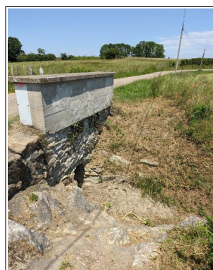
Figure 41 : Passage busé sous la route au niveau de la zone humide de Fayolle.
