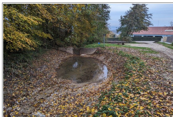
Figure 25 : Premier bassin décanteur. Dans le cas d'embâcles sur la grille, l'ouvrage peut être submergé.
