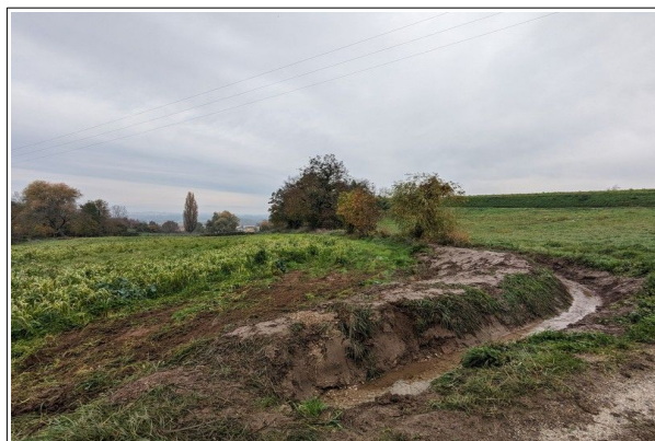
Figure 33 : Ruisseau du Revollay / Gattaz-Fer dont le fossé a été curé et recreusé suite aux débordements de l'automne 2023.
