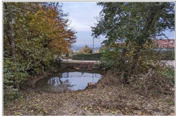
Figure 27 : Second bassin décanteur. Dans le cas d'embâcles sur la grille, l'ouvrage peut être submergé. Les écoulements empruntent alors l'Avenue des Noyers.
